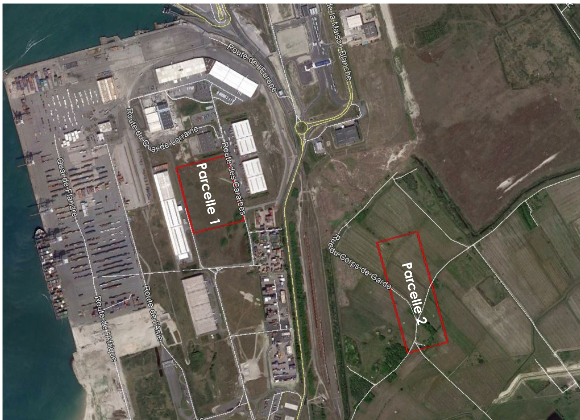
Figure : Vue aérienne du site dans son proche environnement (vues antérieures aux travaux sur la DLI SUD)
